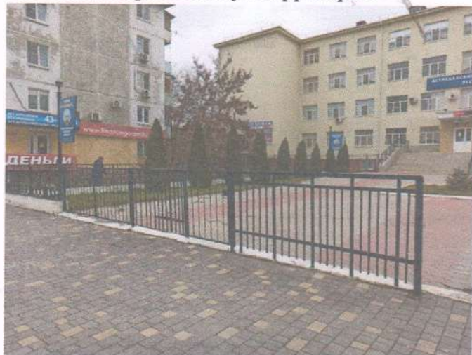
№3. Вход на прилегающую территорию
